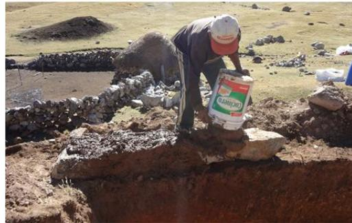
**ZANJA PARA EL REACTOR DEL BIODIGESTOR**
