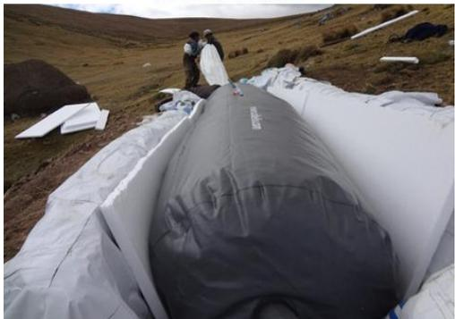
**PREPARANDO CUBIERTA DEL TECHO DEL BIODIGESTOR**
